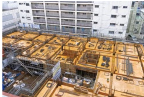
躯体工事状況
