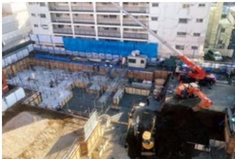
基礎工事状況
