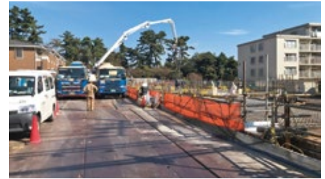
三方が住宅に囲まれたなかでの施工状況 (写真提供:川口土木建築工業)
